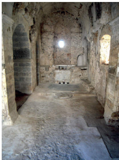
Εικ. 3 : Ναός του Αφέντη Χριστού στην Κριτσά. Εσωτερική άποψη του νότιου κλίτους κατά τις εργασίες διερεύνησης.
