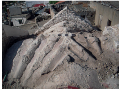
Εικ. 4 : Ναός του Αφέντη Χριστού στην Κριτσά. Το σταυροθόλιο του προσκτίσματος με την αρχική κεράμωση του 14ου αι.
