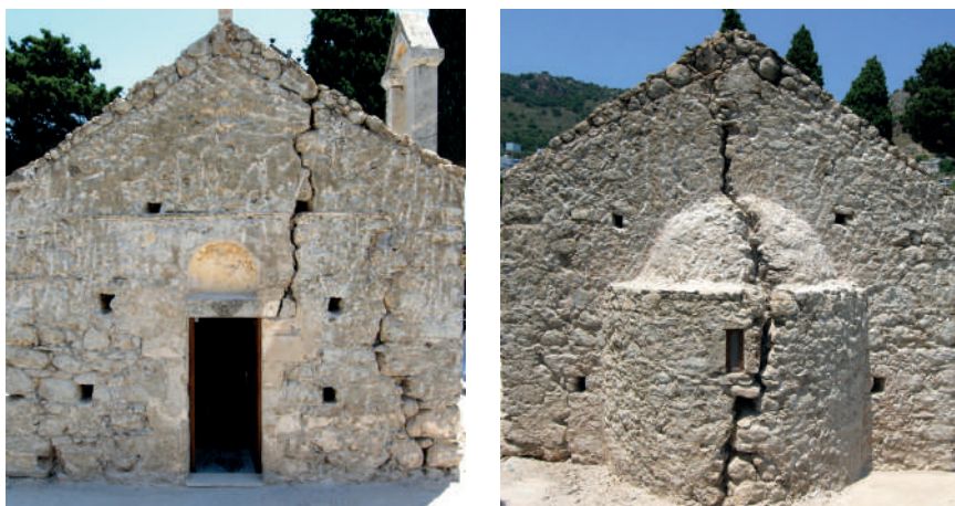
Εικ. 3 & 4 : Τοιχοδομία και ρωγμές δυτικής και ανατολικής όψης.
